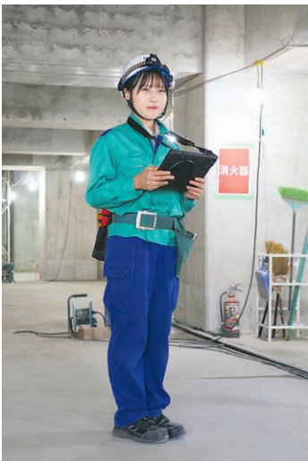
屋内配線工事に従事する女性技術者
