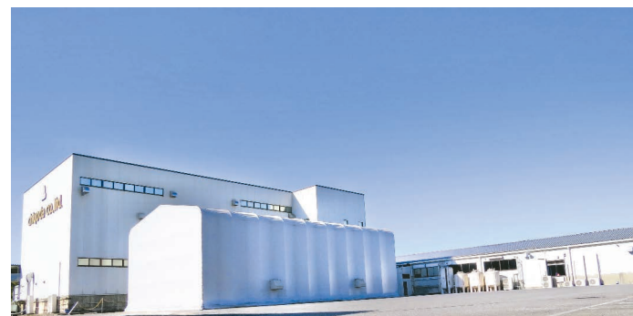
真壁工場（茨城県桜川市）
